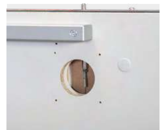
Wartungsöffnung für Schließbolzen
